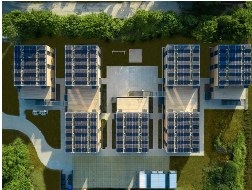
Рис. 2.4 - фотоелектричні модулі встановлені на дахах
